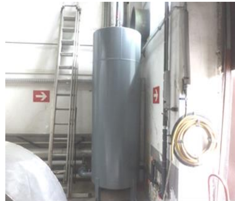
Izmjenjivač toplote za hlađenje vode od odmuljivanja i odsoljavanja kotlova u posmatranom pogonu
